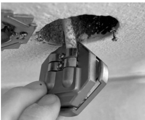
3. Kabel in Zugentlastung einführen und Schirmung einklemmen.
