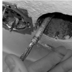
2. Abisolieren und Schirmung um Kabel wickeln
